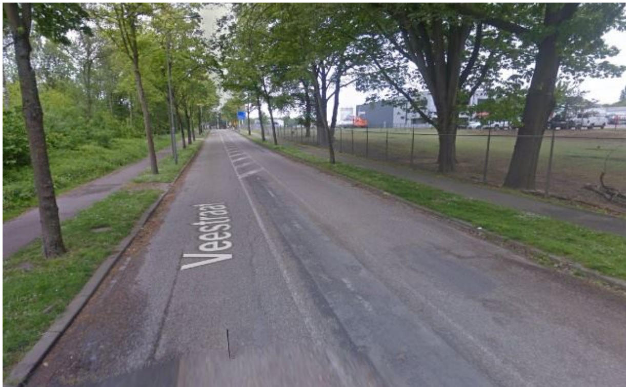
Figuur 17. Voorbeeld: Veestraat, is de verbinding van Urmond naar Stein, hier zijn vrijliggende fietspaden beschikbaar, maar is de inrichting erg smal en beperkt. In de kernen zijn de vrijliggende fietsvoorzieningen erg goed, maar tussen de kernen is de kwaliteit beperkt.
